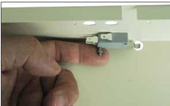
a. Inserire lo switch di tamper nell'apposito perno predisposto sul contenitore della centrale, avvitando il dado in dotazione e facendo attenzione affinché lo switch possa ruotare liberamente
