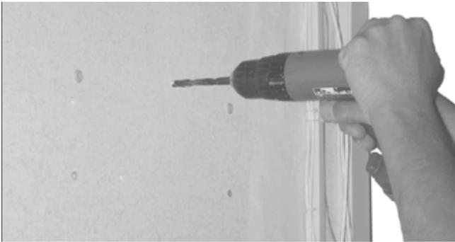
Per prima cosa eseguire i fori al muro per il fissaggio del contenitore della centrale Amica.
